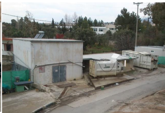
Εικόνα 7: Χώρος προσωρινής Αποθήκευσης Αποβλήτων
